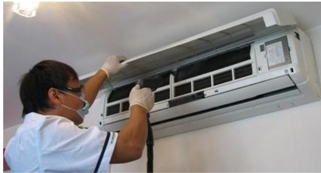
4. Disinfezione del pacco lamellare e del filtro con un prodotto ad azione antibatterica e germicida in formulazione aerosol che lascerà anche un gradevole e persistente profumo di fresco e pulito.
